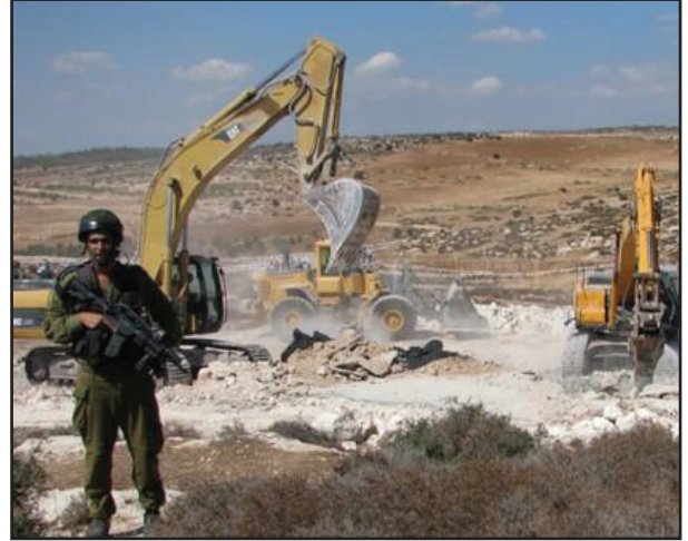
صورة(٢): هدم المباني
